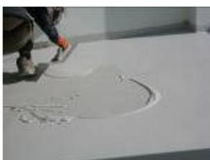
Sulla superficie opportunamente primerizzata, quando secco al tatto, posa in opera di **rivestimento elastoplastico** bicomponente, impermeabile, anticorrosione, atossico, flessibile, antifessura. La prima mano di prodotto dovrà essere applicato a lama per 1 mm di spessore.
