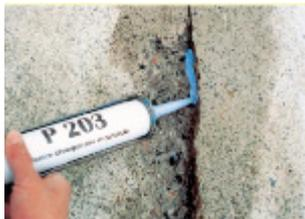
Scarifica per una profondità minima di 7 cm di tutte le fessurazioni, le riprese di getto ed i contorni dei corpi passanti. Sigillatura degli scassi con estrusione di minimo 1cm di cordolo continuo di gomma idroespansiva in cartuccia
