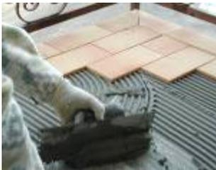
Fornitura e posa di adesivo cementizio ad alte prestazioni, per piastrelle ceramiche e materiali lapidei; monocomponente marcato CE tipo C2TE ad alta tixotropia, lungo tempo di lavorabilità e resistente all'acqua e al gelo.
